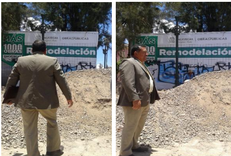
Supervisando avances del proyecto en el centro de fresnillo.
