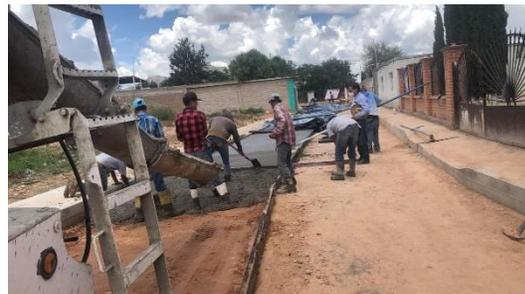
**OBRA:** CONSTRUCCION DE PAVIMENTO, GUARNICIONES Y BANQUETAS
