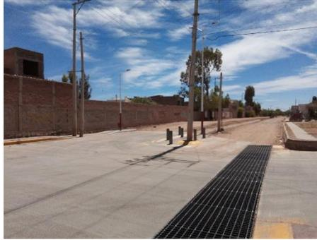
**OBRA:** PAVIMENTACION DE 1,756.79 m2 A BASE DE CONCRETO HIDRAULICO
