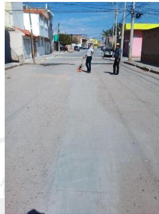
**OBRA:** CONSTRUCCION DE PAVIMENTO CON CONCRETO HIDRAULICO
