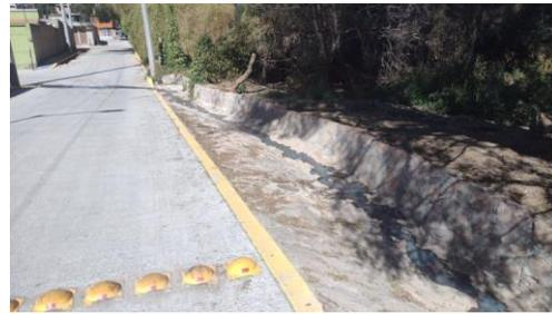
**OBRA:** PAVIMENTACION DE 2,622.00 M2 CONCRETO HIDRAULICO
