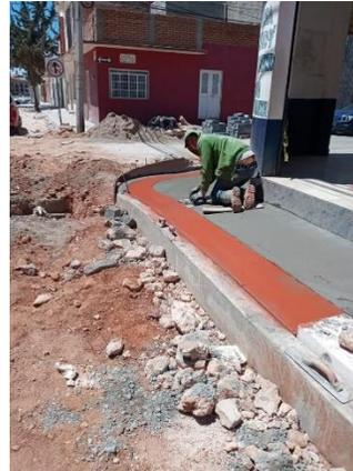
**OBRA:** CONSTRUCCION DE PAVIMENTACION DE CONCRETO HIDRAULICO
