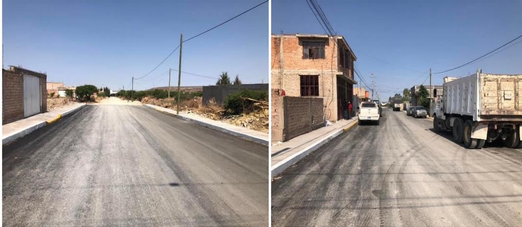
**OBRA:** PAVIMENTACIÓN DE 3,309 M2 A BASE DE CONCRETO HIDRÁULICO
